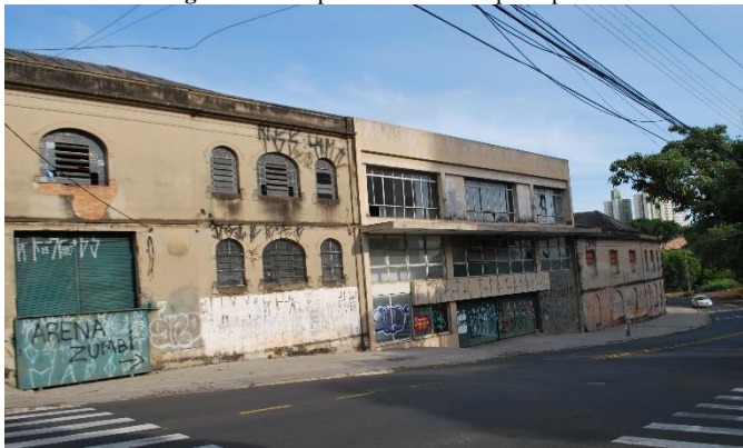
Figura 3. Vista parcial da fachada principal.
